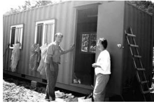
<임시숙소용 컨테이너 설치> 여섯명의 인명피해가 발생한 양양읍 거마리에 이재민을 위한 임시숙소용 컨테이너 박스가 설치됐다.
